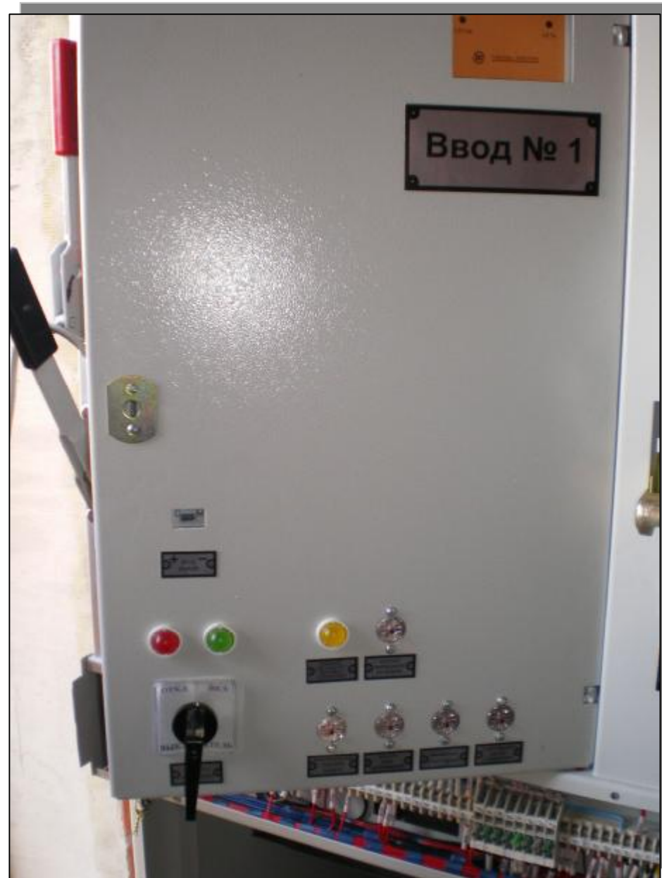
Размещение аппаратуры управления выключателем и указательных реле на дверце
