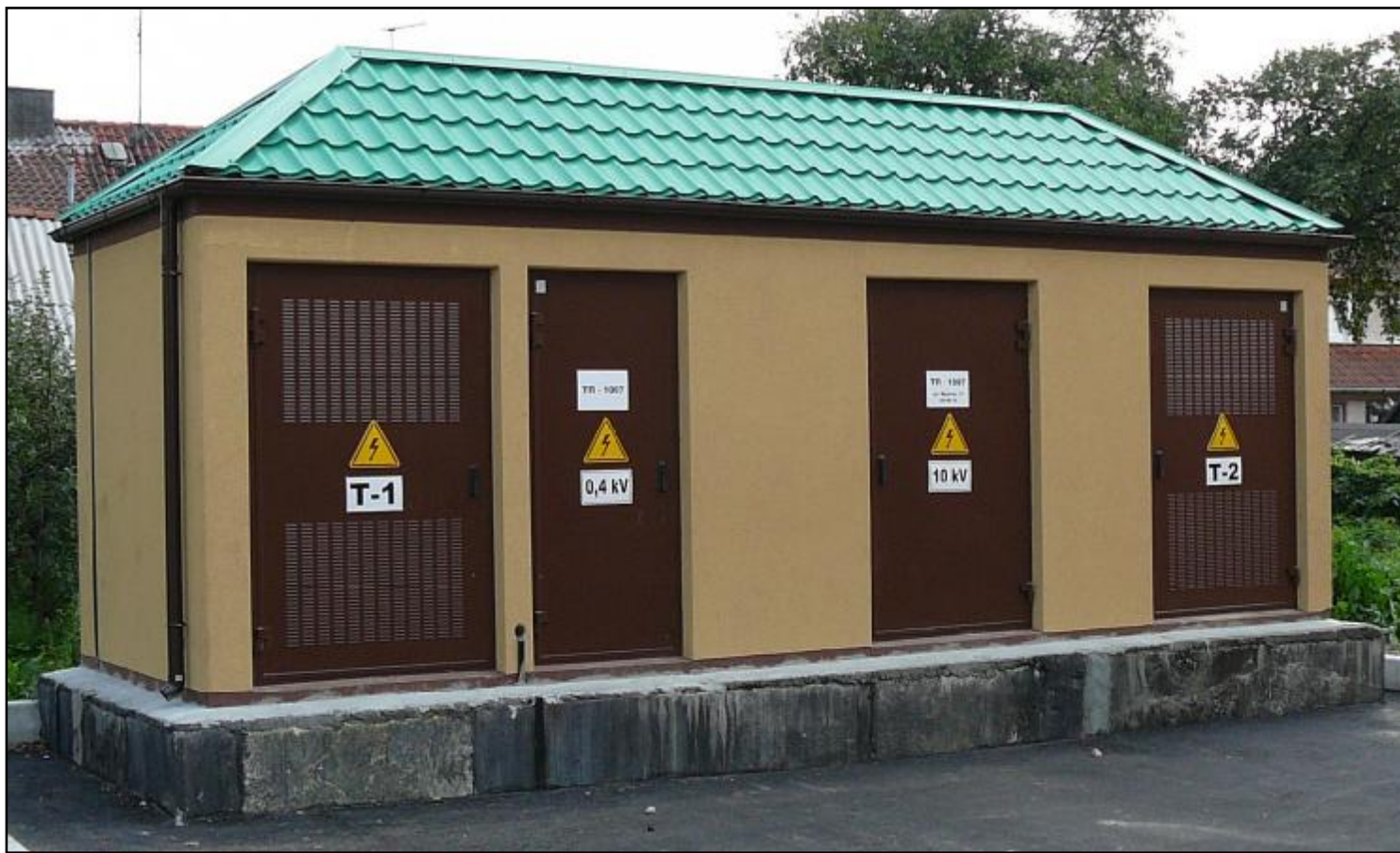
Распределительный пункт 10 кВ с 2-мя силовыми трансформаторами и распределительным устройством низшего напряжения
