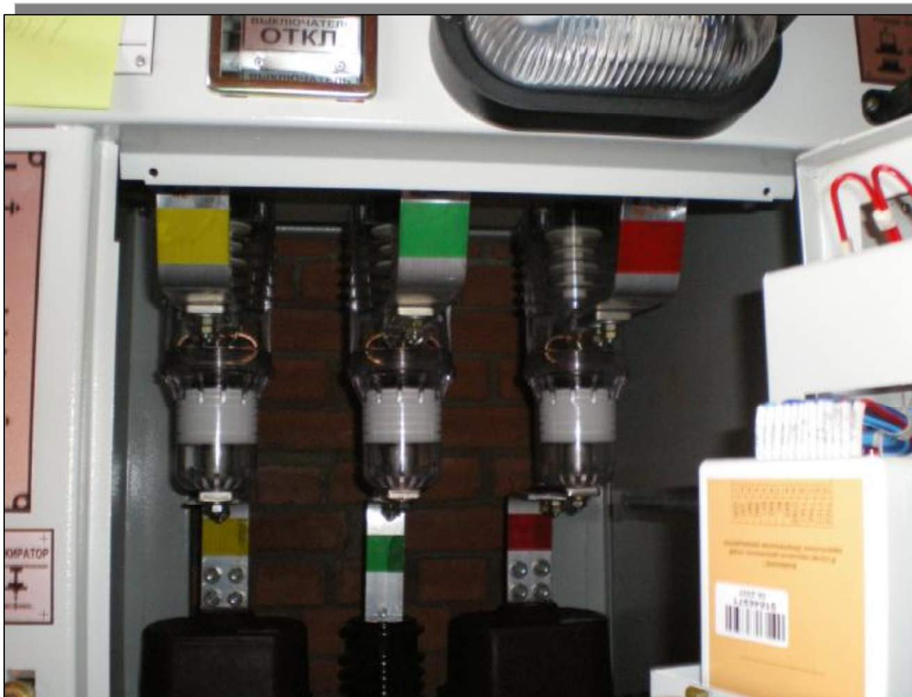
Вакуумный выключатель BB/TEL
