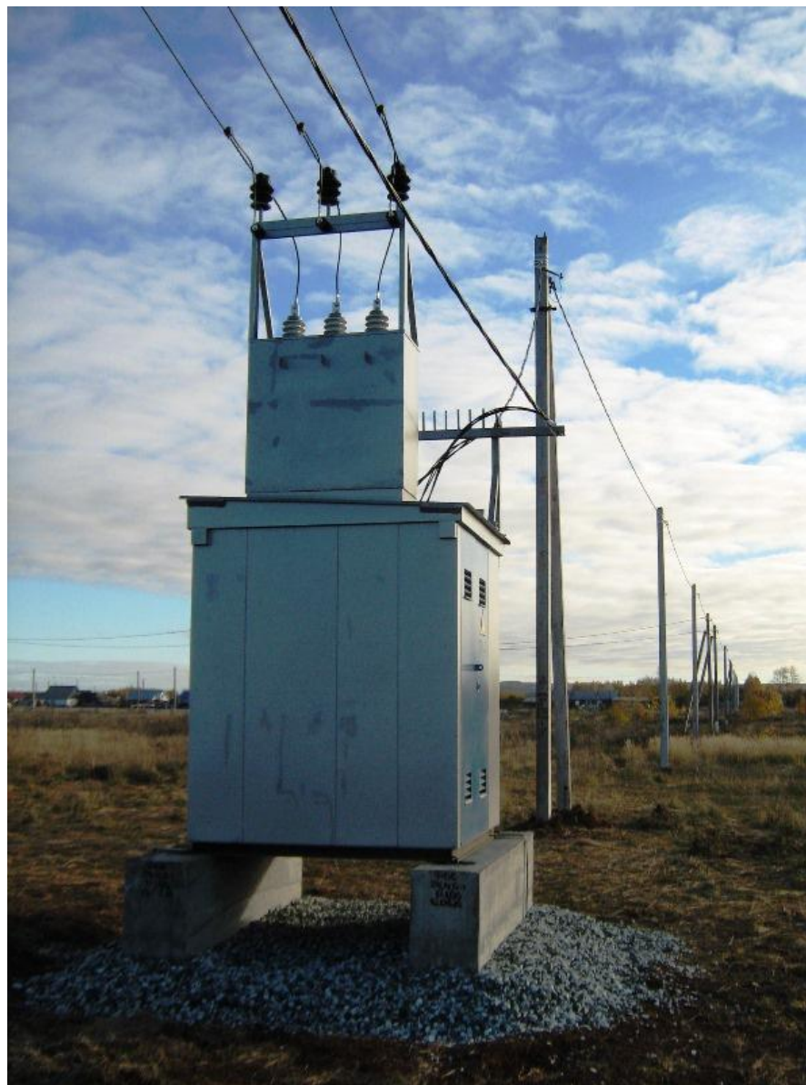
ВЛ 10 кВ с установленной КТП
