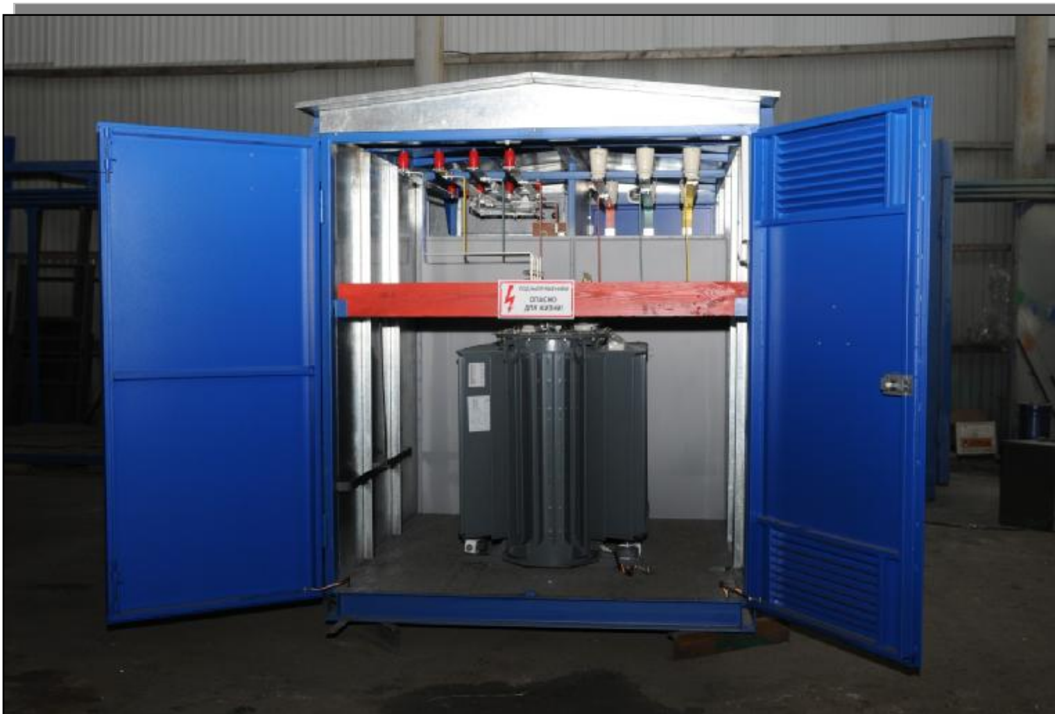
Отсек силового трансформатора КТП
