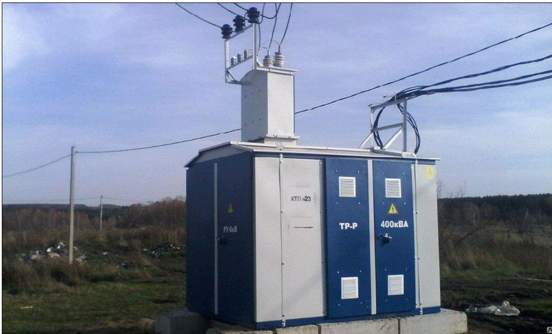
Однотрансформаторное КТП 6/0,4 кВ мощностью 400 кВА с воздушным вводом и воздушными выводами
